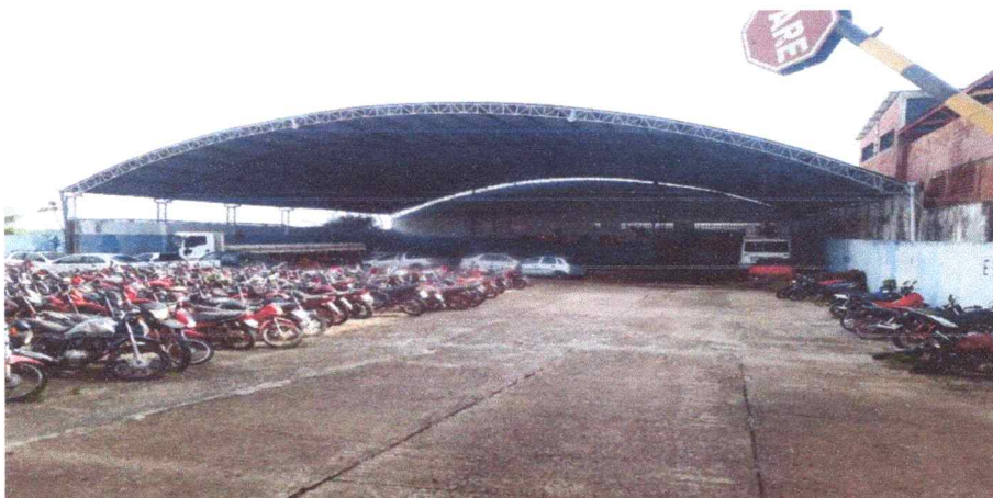
Figura 5 - Área interna - pátio
